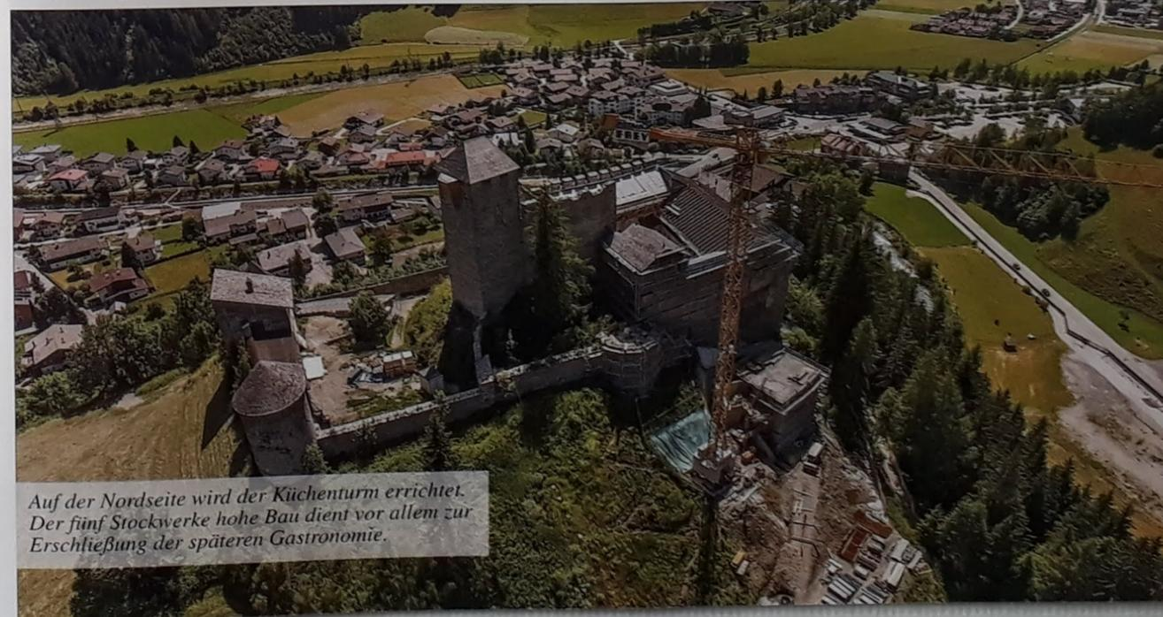
Auf der Nordseite wird der Küchenturm errichtet. Der fünf Stockwerke hohe Bau dient vor allem zur Erschließung der späteren Gastronomie.
